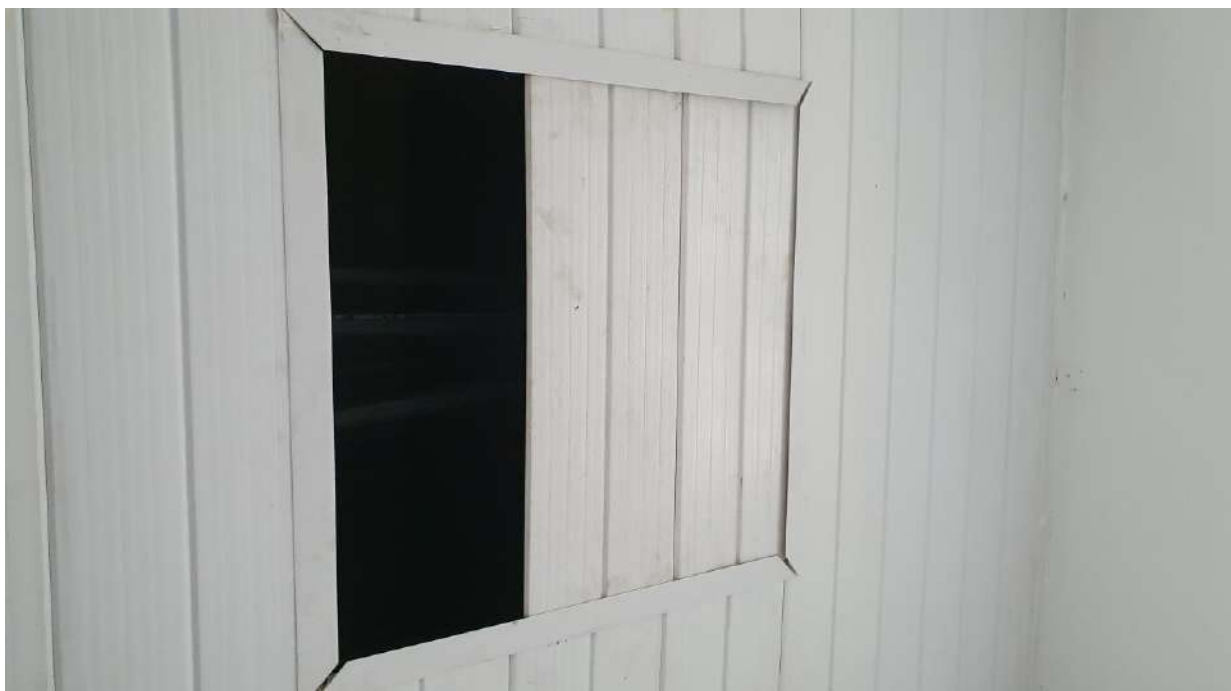
Fotografia 9 – Tampa de acesso ao forro danificada – Fonte TRE/PI.
