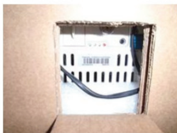
Foto 7 - Janela para visualização do patrimônio e passagem do cabo de força
