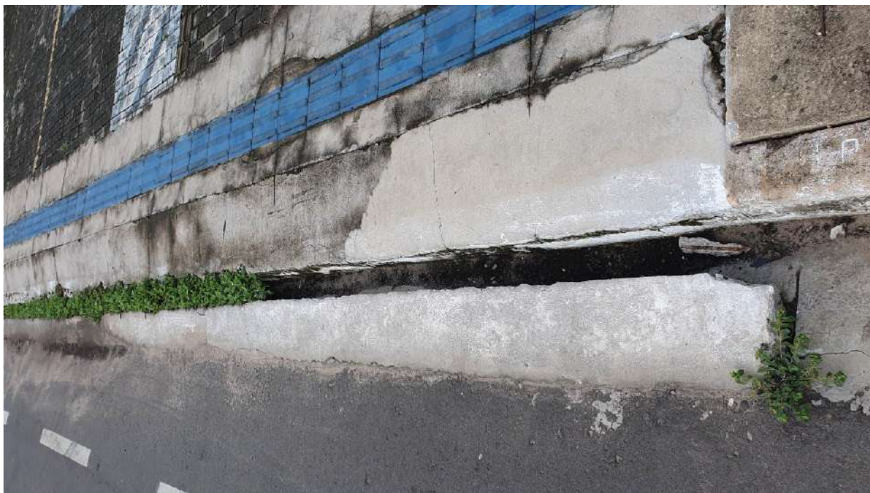
Fotografia 8 – Rampa de acesso aos veículos – Fonte TRE/PI.
