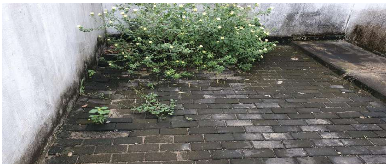
Fotografia 15 – Piso em bloquete a ser recuperado – Fonte TRE/PI.
