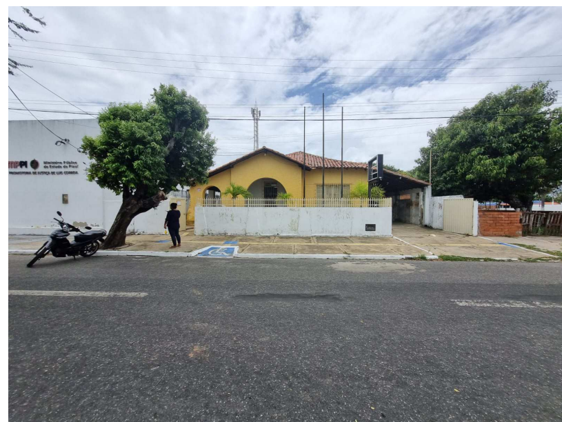
IMAGEM DA FACHADA ATUAL
