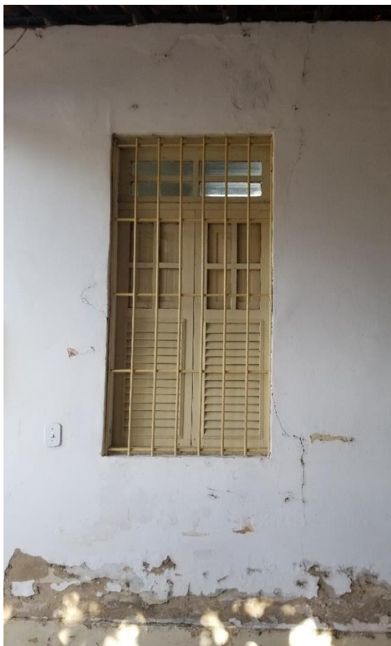
Figuras 4 e 5 - Fissura ao lado da esquadria e reboco esfarelando
