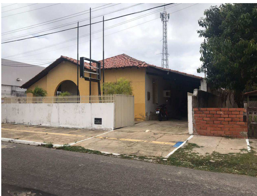
IMAGEM DA FACHADA ATUAL
