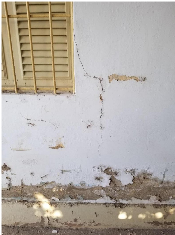
Figuras 4 e 5 - Fissura ao lado da esquadria e reboco esfarelando
